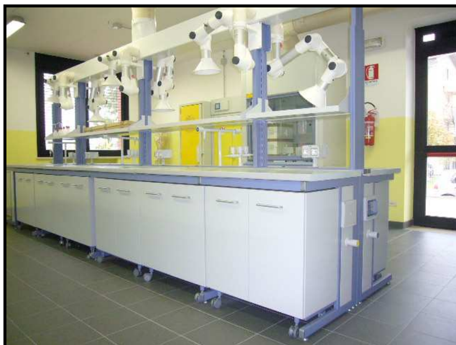
6) banchi centrali per laboratori di chimica con sistema di aspirazione centralizzata.
