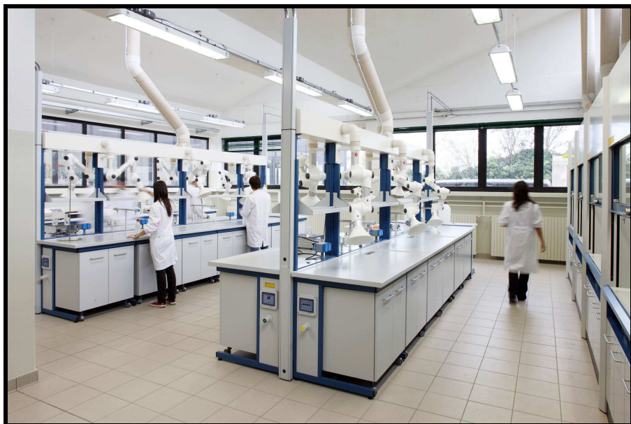
1) banchi centrali per laboratori di chimica con sistema di aspirazione centralizzata.
