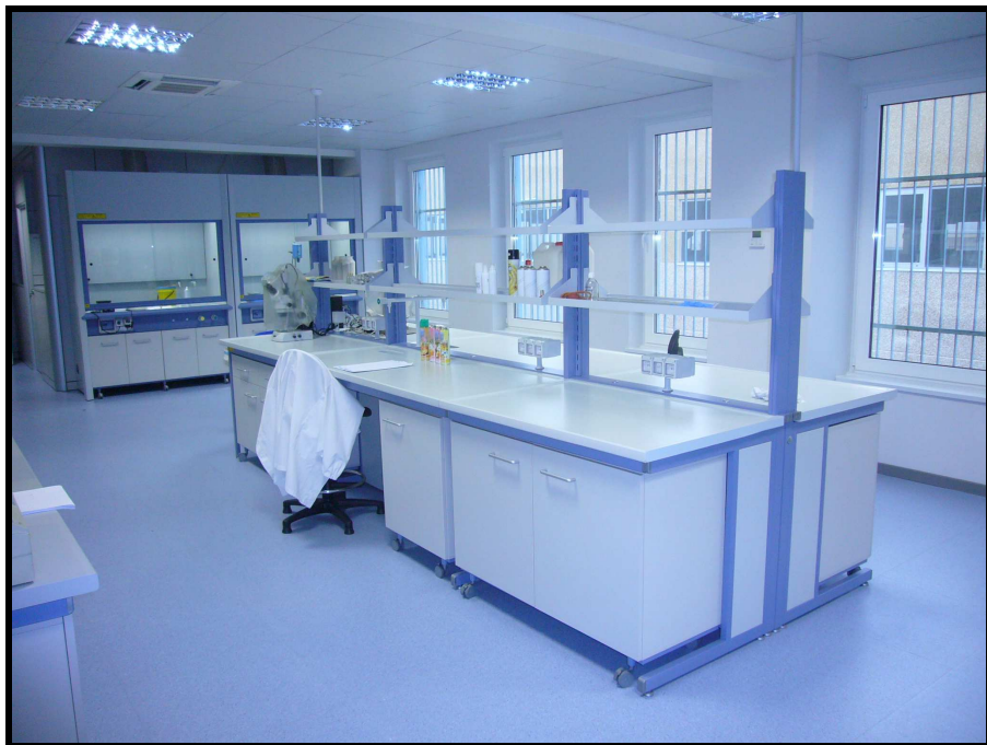
19) banco centrale con alzata tecnica aperta
