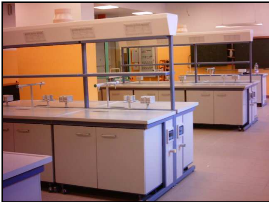
25) banchi centrali con sistema aspirazione fisso.
